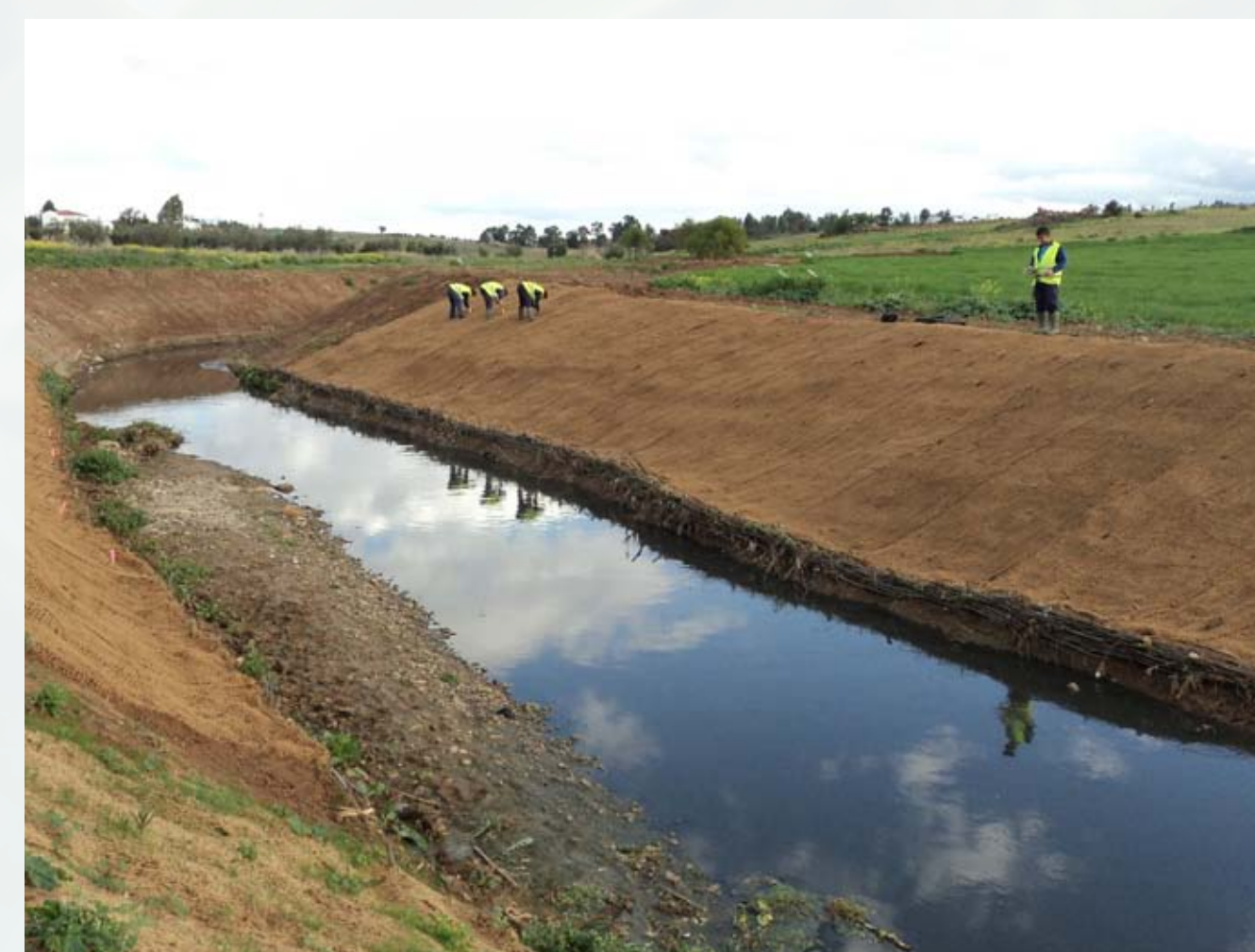
Figura 9. Recubrimiento con red de coco y plantaciones.
